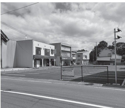
完成した中心商店街駐車場＝木造千代町57番地、58番地
