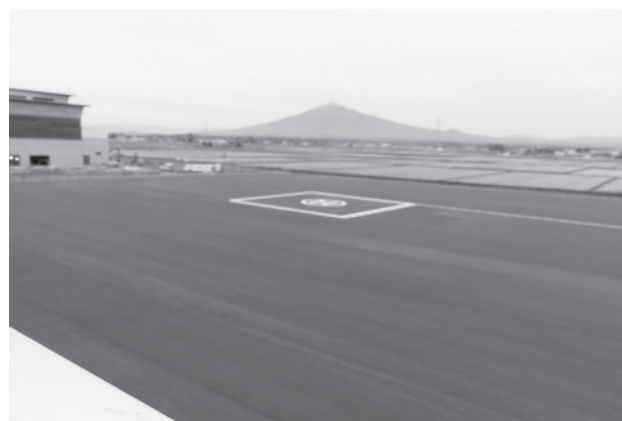
備蓄倉庫西側に整備されたヘリポート
