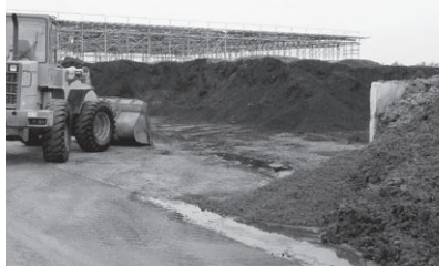
「H19年度事業で屋根が掛かった堆肥盤」 (手前は今年の事業で屋根が掛かる予定)
