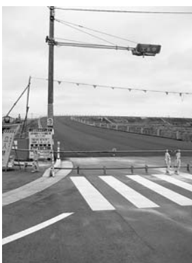
供用開始が待たれる (仮称) 柏インターチェンジ
