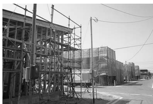
建設中の桜木団地
