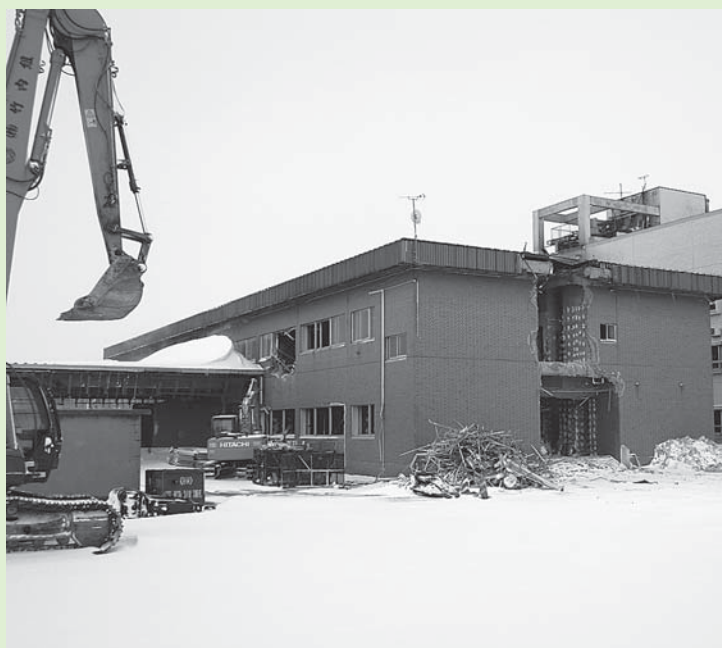
解体が始まっている旧成人病センター
