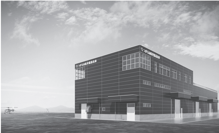
（仮称）つがる市総合体育館北側に建設されます
