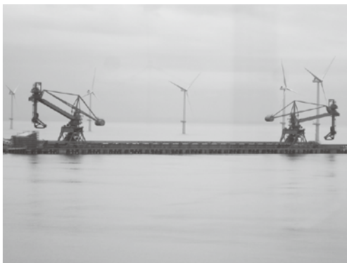
能代市の洋上風力発電機
