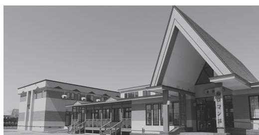
左奥が増築部分
