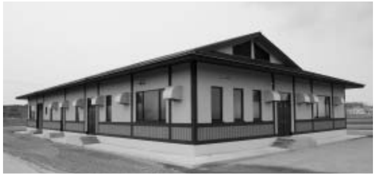
完成した越水地区農業集落排水処理施設
