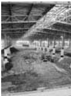
木造稲垣一般廃棄物最終処分場
