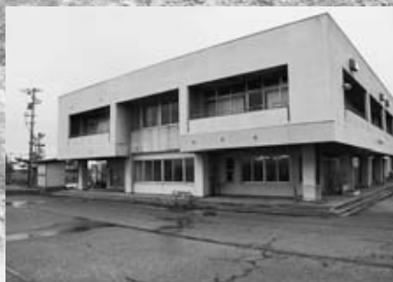
老朽化した木造斎場
