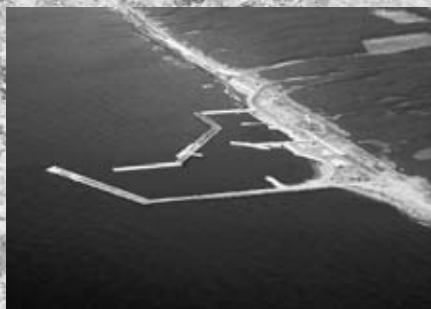
整備が進む車力漁港
