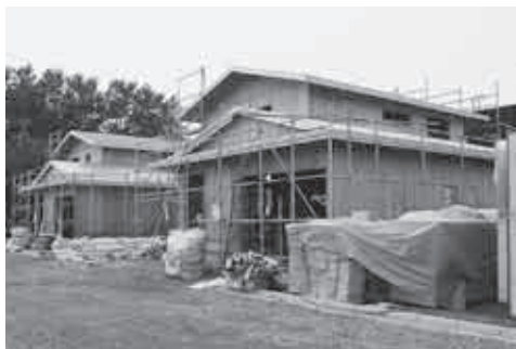
柏上古川に建設中の住宅
