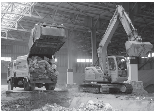
収集車によって木造稲垣一般廃棄物最終処分場に 運搬される燃えないごみ
