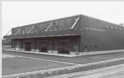
集出荷氷温貯蔵施設建設工事
