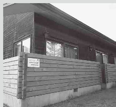
つがる地球村整備事業(藤山邸ベランダ改修)
