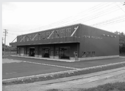
集出荷氷温貯蔵施設建設工事
