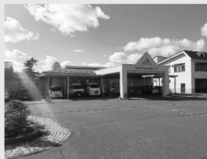
車力老人福祉センター屋根改修工事
