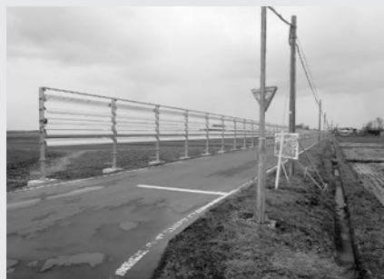
萩野下遠山里線防雪柵設置工事
