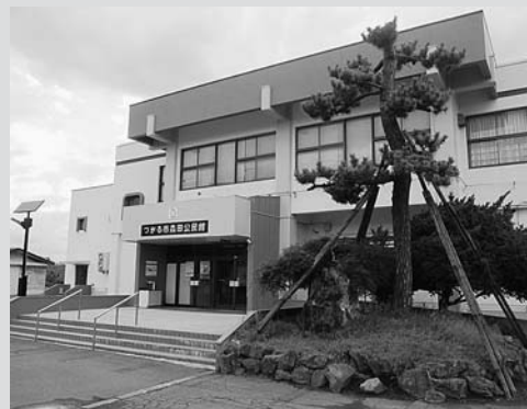
森田公民館外壁改修工事
