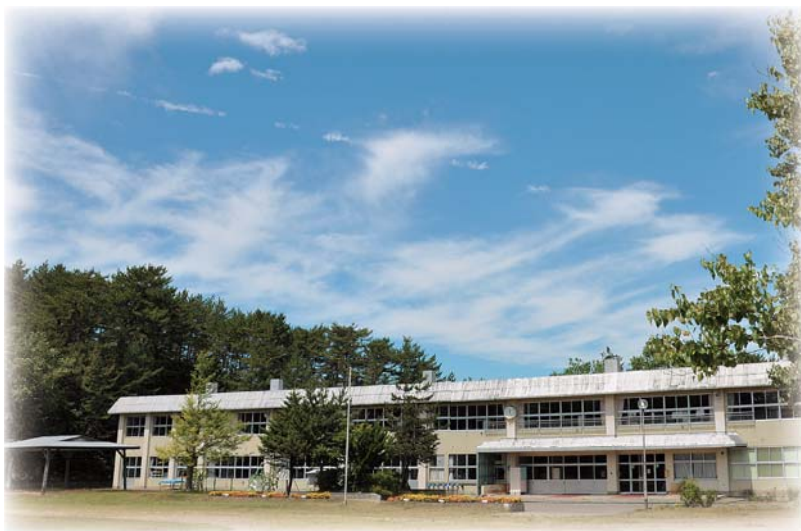
車力小学校校舎
