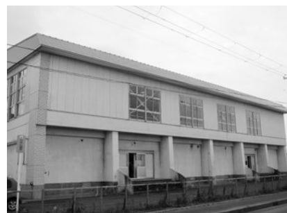
柏小学校体育館（屋根改修）
