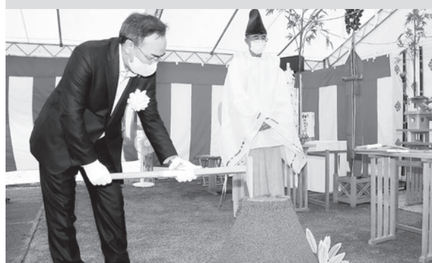
防災の拠点となる備蓄倉庫とヘリポートの工事の安全を願い、くわを入れる倉光市長
