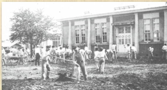
生徒たちが校庭整地作業を行っている。右奥には講堂が見える（昭和4年の講堂完成間もない頃に撮影したと思われる）
