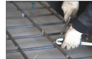
鉄筋結束の様子
