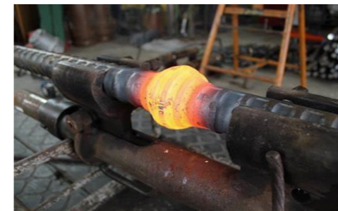
例：圧接後の鉄筋
