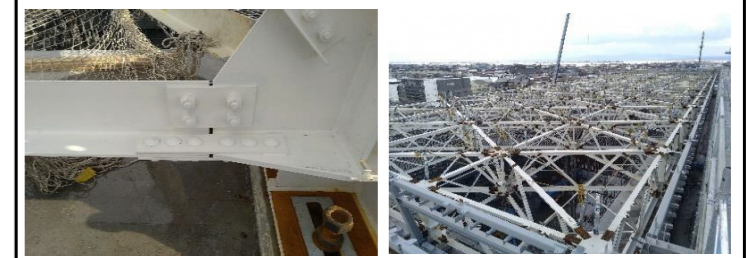
ジョイント部分塗装完了
