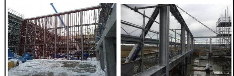
間仕切り鉄骨
