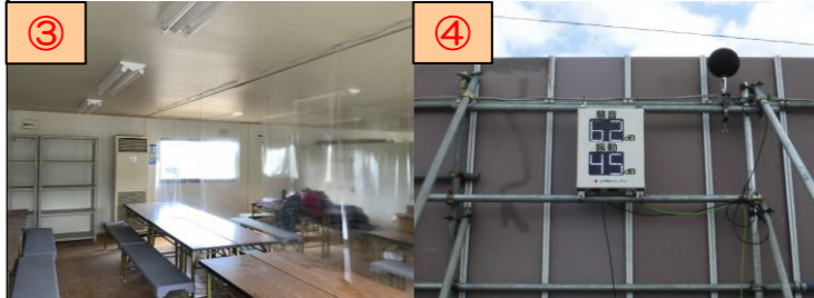
休憩時の消灯 騒音・振動計の設置
