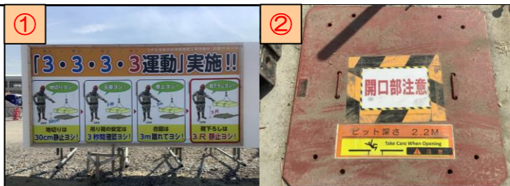
適切なクレーン作業方法の掲示 墜落危険箇所の表示
