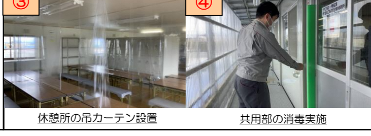
休憩所の吊カーテン設置 共用部の消毒実施
