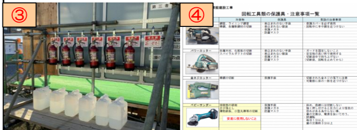
現場内消火器の配置 電動工具の正しい使用方法を掲示
