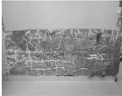
写真-2 床版下面損傷状況
