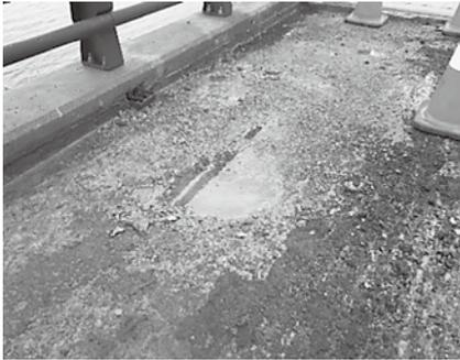
写真-1 床版上面損傷状況
