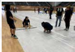
体育館一面を養生する
