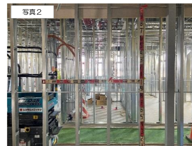
5m超えの壁には、 中間に鉄骨梁を設けています
